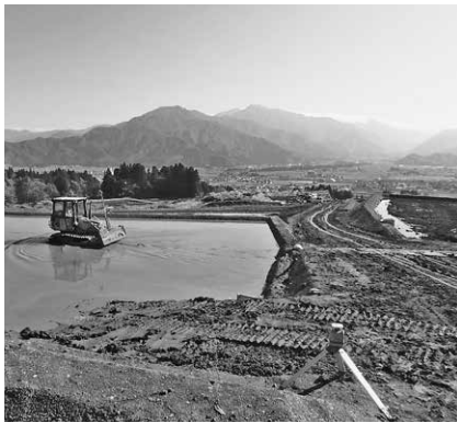
泉盛寺開田地区 湛水整地の状況
