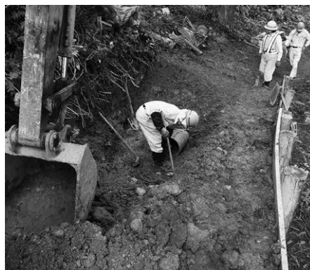
蕪甲水系地区 工事状況
