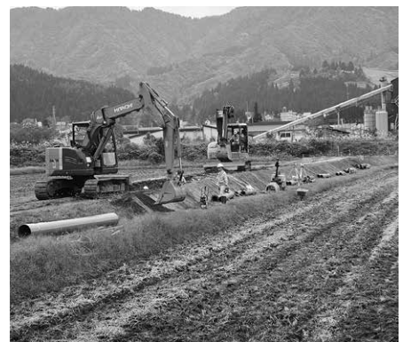
姥島地区 工事状況
