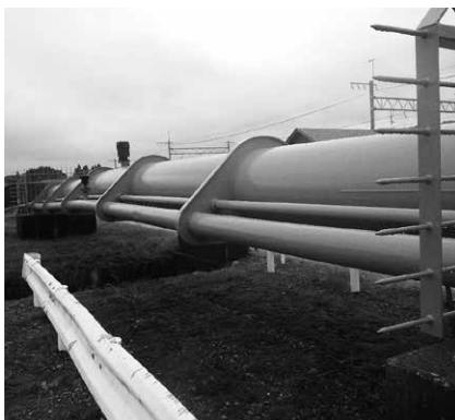
大巻藪神第3地区 塗装工事完了
